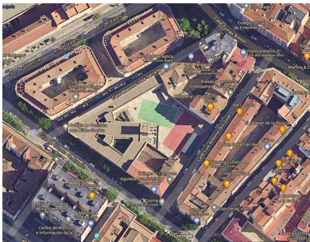
Plano de situación del centro educativo y señalización de entrada en Calle Luis Oro Giral
